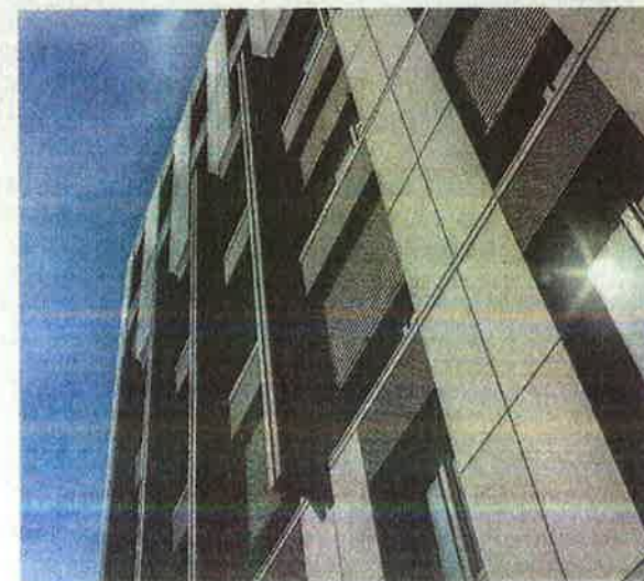
Vertikale Pflanzwände sorgen auf den Treppenabsätzen und im Eingangsbereich für tropisches Begleitgrün und Gewächshaus-Effekt (oben). Unauffällig integrieren sich die neuartigen Photovoltaik-Paneele dank ihrer dünnen Farb-Beschichtung in die von senkrechten Lisenen strukturierte Fassade (unten).
