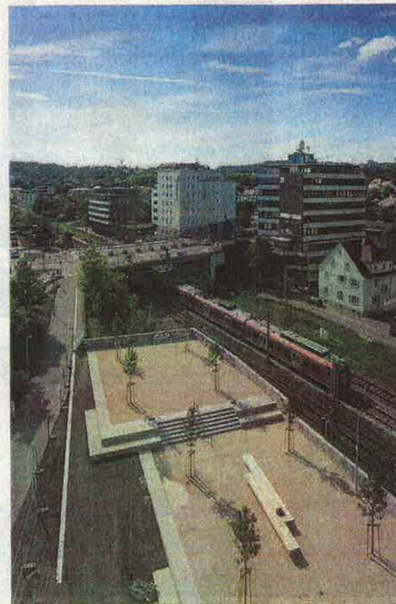
Eine Freifläche, die auf ihr Publikum wartet: Der Blick aus der „Westspitze“ nach Westen (im Hintergrund die Blaue Brücke mit Blauem Turm, rechts, und Ibis-Hotel gegenüber) zeigt den spitz zulaufenden öffentlichen Platz zwischen Bahnlinie und Brückenrampe, mit Sitztreppen und jungen Bäumen.
